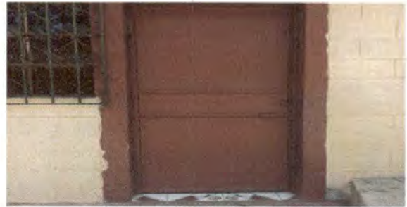
Foto 26: Mantenimiento a estructura( lijado, cambio de tubo, cepillado, sujeciones, aplicación de pintura) (módulo de cocina)
