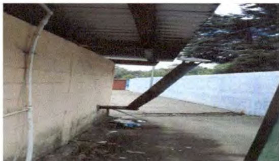
Foto 21: Sustrucción de chimenea de metal (módulo de cocina)
