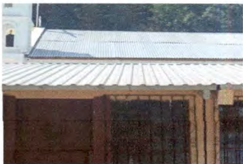
Foto1: Sustrucción de elementos de fijación (módulo de aulas)
