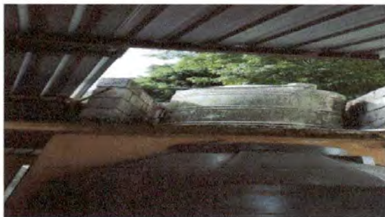
Foto19: Sustrucción de deposito de agua 1100 Lt. (módulo de baños)
