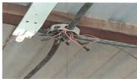
Foto 12: Instalación de unidades de fuerza (tomacorriente), incluye cable electrico (módulo de aulas)
