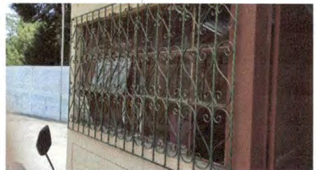
Foto 28: Sustitucion de vidrios (módulo de cocina)
