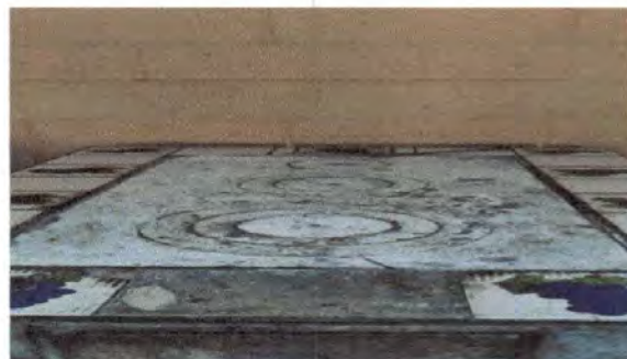
Foto 20: Sustrucción de plancha de metal de 3 hornillas (módulo de cocina)
