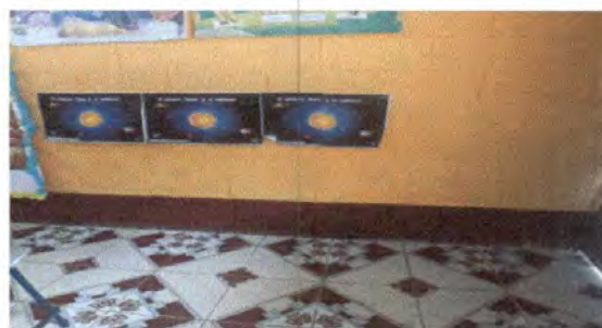
Foto 10: Pintura en muros interiores (módulo de aulas)
