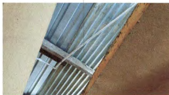
Foto 16: Instalación de tubería principal de pvc (módulo de baños)
