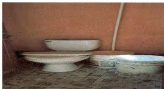
Foto 15: Sustitución inodoro (módulo de baños)
