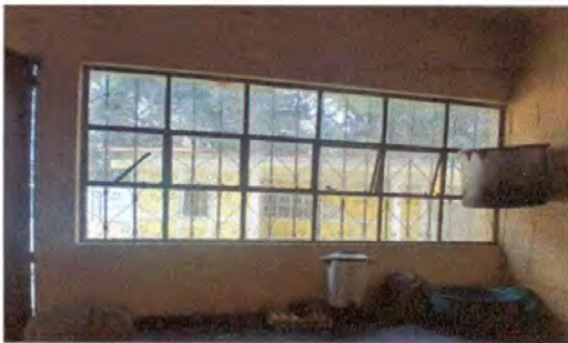
Foto 27: Mantenimiento a estructura de metal de ventana (módulo de cocina)
