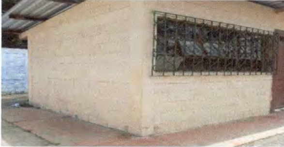
Foto 25: Pintura en muro exteriores (módulo de cocina)
