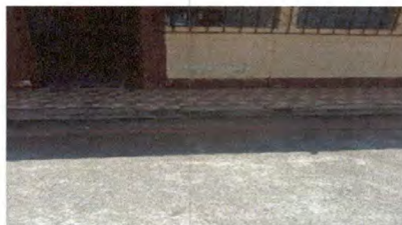
Foto 8: Sustrución de piso cerámico (módulo de aulas)
