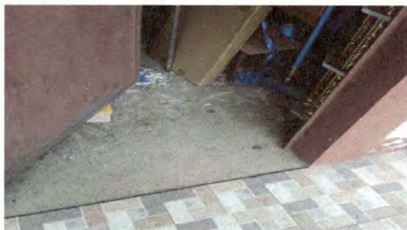
Foto 7: Sustrución de piso de concreto (módulo de aulas)
