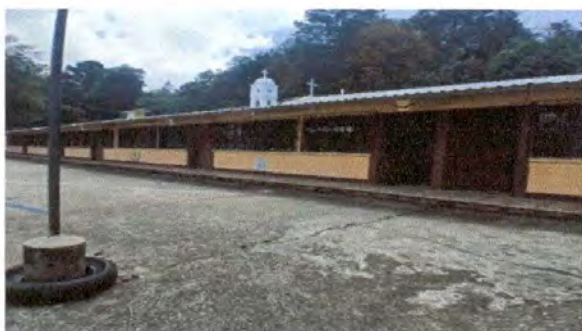
Foto 9: Pintura en muros exteriores (módulo de aulas)
