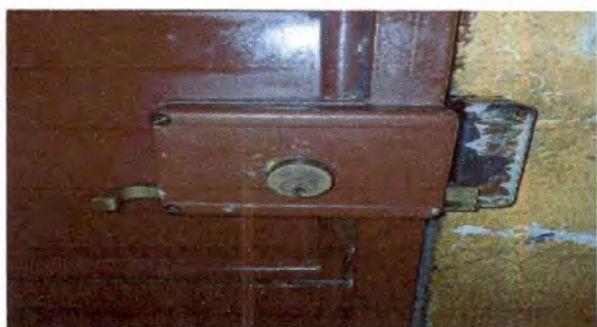
Foto 3: Sustrucción de chapa (módulos de aulas)
