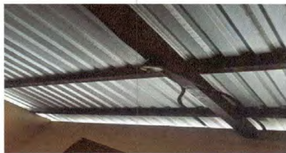
foto 22. Instalación de unidades de luz (módulo de cocina)
